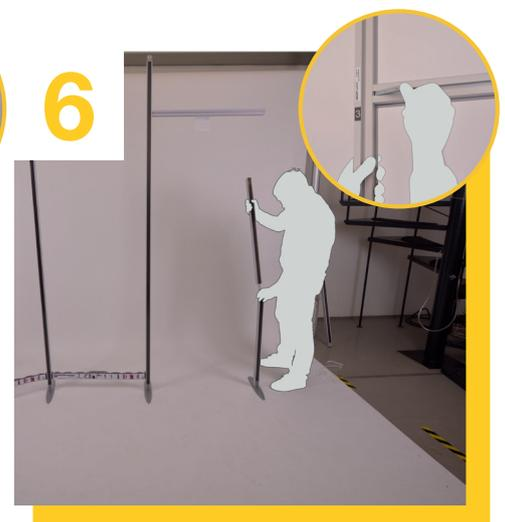
Beim 3. Modul montieren Sie im oberen Bereich die Querstrebe für die Kühlschrankausparung.
