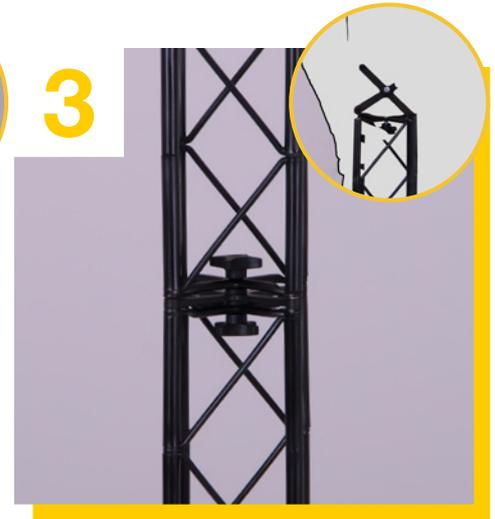
Verbinden Sie die Längstraversen mit Hilfe des Verbindungskreuzes!
